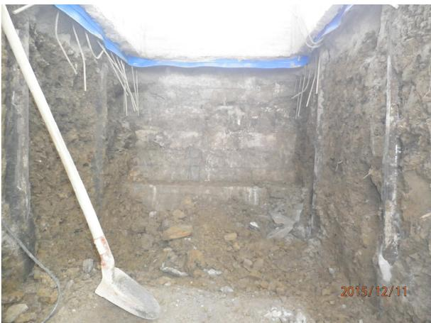
[Fig. 8].- Vista de la primera fase de excavación en el tramo de pasillo. Al fondo el trasdós del muro de contención entre la calle inferior y el acceso a la vivienda.
