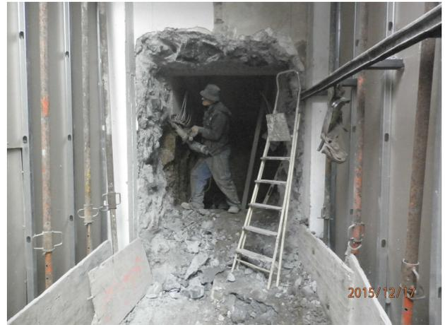
[Fig. 10].- Picado del acceso al pasillo desde la calle inferior a través del muro de contención
