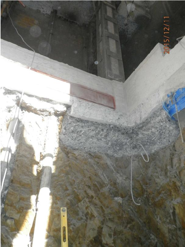
[Fig. 7].- En las primeras fases de excavación se eliminó la parte de la zapata que quedaba fuera del recalce
