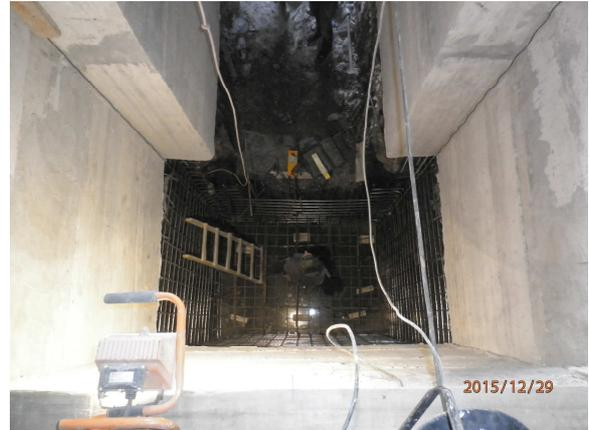
[Fig. 9].- Vista de la caña del ascensor durante el encofrado de la última fase
