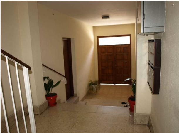
[Fig. 2].- Vista general del portal donde se observa que existen varios tramos de escalera que constituyen las barreras arquitectónicas que se pretende eliminar con la instalación del ascensor.
