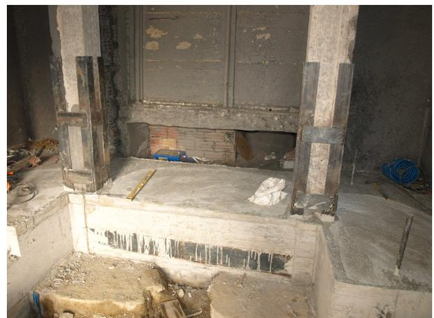
[Fig. 8].- Con el hormigonado, la parte de las zapatas que se debía demoler quedaba fuera del recalce
