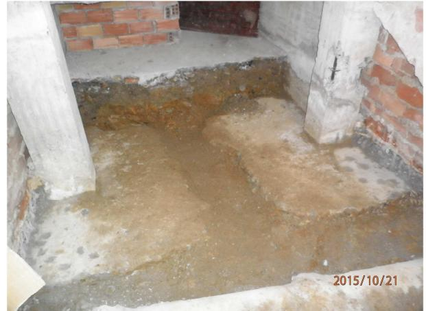
[Fig. 7].- Demoliciones en torno a las zapatas afectadas, se puede observar que el poste derecho está deteriorado
