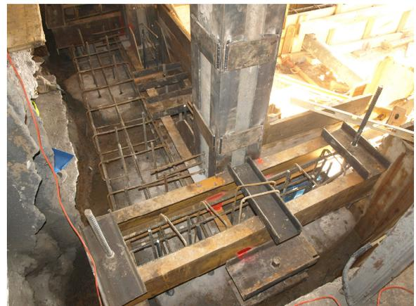
[Fig. 8].- Entramado metálico para transferir los esfuerzos desde los postes empresillados a los micropilotes de recalce
