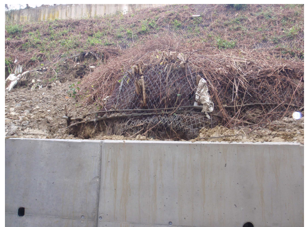
[Fig. 5].- Bolsón observable en el pie del talud
