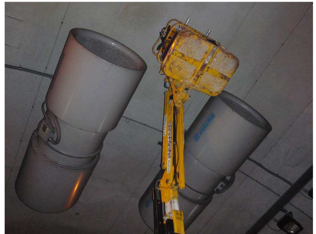
[Fig. 7].- Efectuando perfil próximo a eje túnel en bóveda con el georadar 3D.
