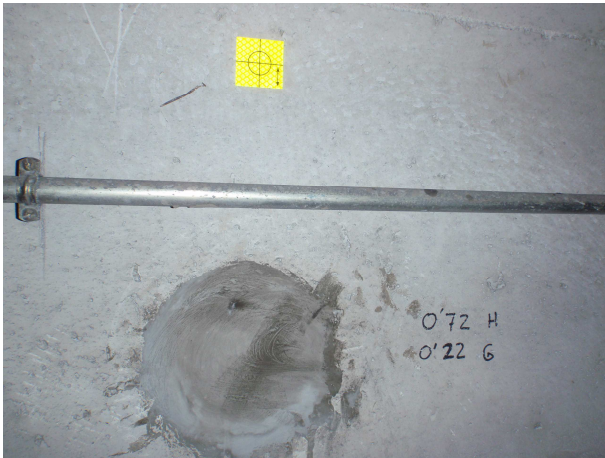
[Fig. 5].- Obturación de las perforaciones con restitución de la lámina impermeabilizante atravesada.
