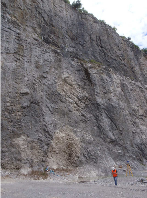
[Fig. 2].- La altura alcanzada en algunos frentes hace difícilmente accesible realizar mediciones en los taludes.
