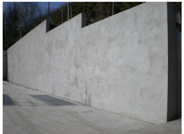
[Fig. 11].-Aspecto del frente del muro forro raseado.
