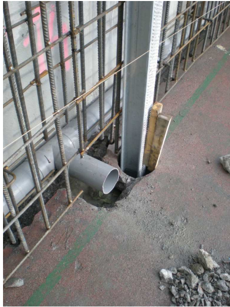
[Fig. 8].- Perfiles zincados, armadura y drenaje previos a la colocación de los paneles prefabricados de hormigón y hormigonado del hueco.
