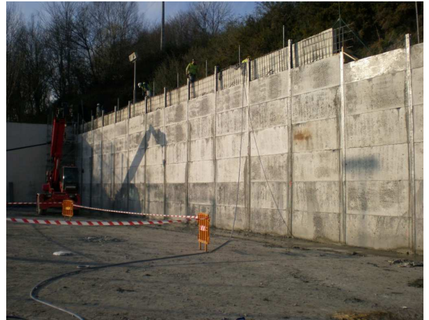
[Fig. 10].- Aspecto del muro forro prácticamente finalizado.
