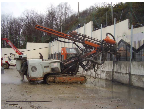
[Fig. 9].-Perforación de anclajes a varias alturas.
