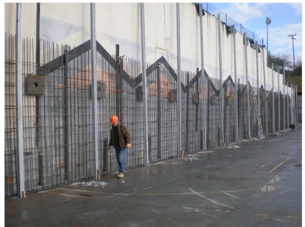
[Fig. 7].-Perfiles y armaduras colocadas.
