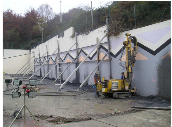
[Fig. 6].- Perforando los alojamientos de los perfiles.
