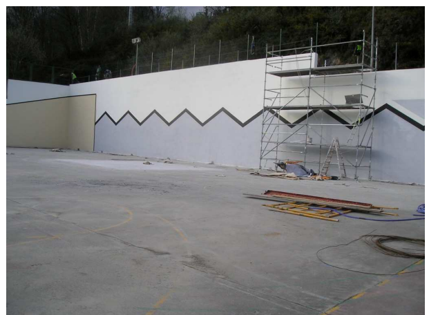
[Fig. 12].- Finalmente el muro se pintó recuperando el patio su aspecto original.
