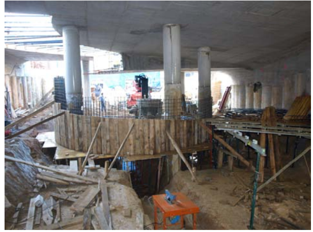
[Fig. 8].- Acodamiento mediante rampa helicoidal.
