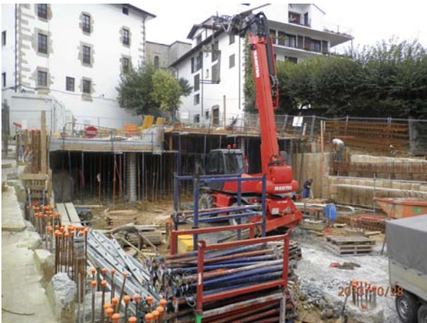
[Fig. 5].- Una vez ejecutada la pantalla de pilotes y los pilotes interiores de estructura, inicio de la excavación.
