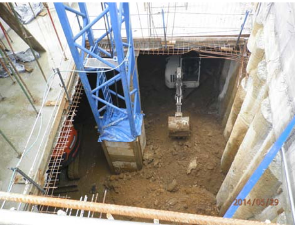
[Fig. 12].- Excavación del tercer nivel de sótano.
