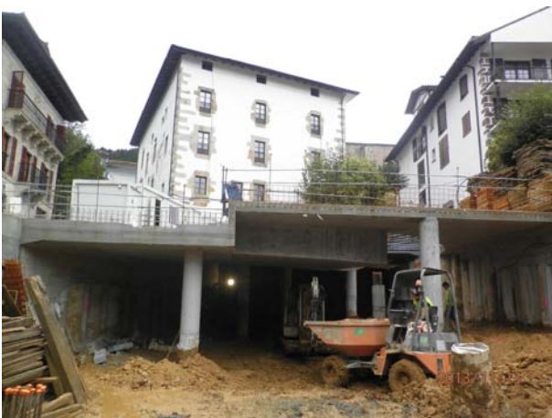
[Figs. 6 y 7].- El acodamiento del hueco en la parte próxima al ayuntamiento, fue el más comprometido debido a la gran masa de las edificaciones colindantes.
