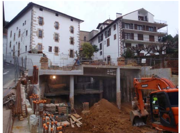
[Fig. 9].- Excavación del segundo nivel de sótano.
