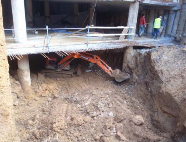
[Fig. 11].- Excavación del tercer nivel de sótano.
