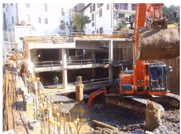
[Fig. 10].- Excavación del tercer nivel de sótano.
