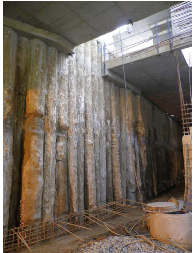
[Fig. 14].- El tramo singular para el paso de las escaleras fue resuelto con más pilotes armados por metro en el tramo de pantalla correspondiente.
