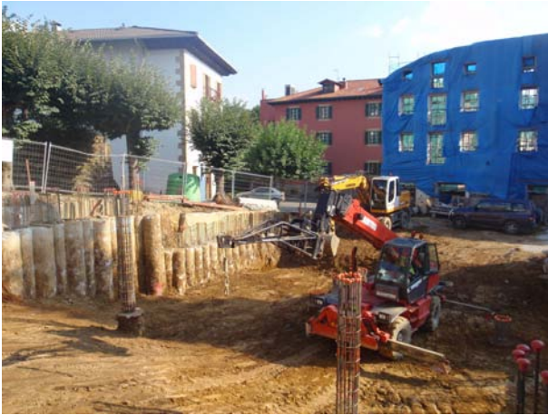
[Fig. 5].- Una vez ejecutada la pantalla de pilotes y los pilotes interiores de estructura, inicio de la excavación.
